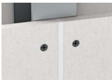
Gipsvoegmethode met rechte kant (RK)
