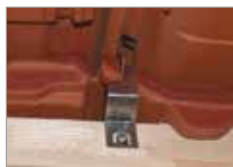
Achter in de pan is een uitsparing gemaakt, waarin de kop van de Multi klikhaak met z'n veerspanning vastklemt.
