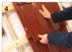
4 De volgende dakpan indekken en aandrukken. Klaar!
