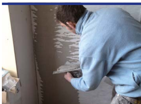
Verlijming direct op het gevelblad. Afwerking met stuc, leem e.d.
