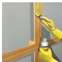
1 B. Houten regelwerk primeren met SikaTack® Panel Primer
