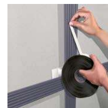
4. SikaTack® Panel Tape aanbrengen
