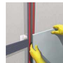
6. De beschermfilm van de SikaTack® Panel Tape verwijderen en vervolgens panelen bevestigen
