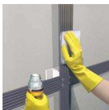
1 A. Aluminium regelwerk opruwen, reinigen met Sika® Aktivator-205 en primeren met Sika® Primer-210
