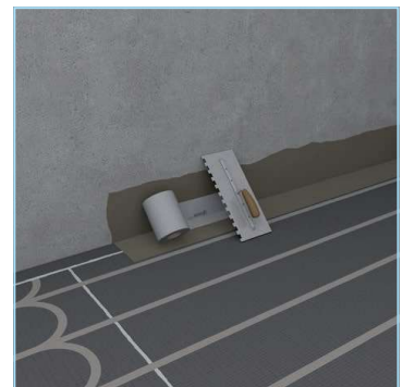
Afdichting van wand en vloer
