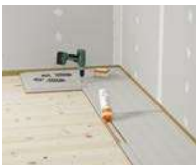
❹ Breng fermacell™ vloerelementen montagelijm aan op de liplas.
