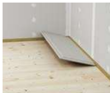
❸ Leg het eerste fermacell® vloerelement in de hoek.
