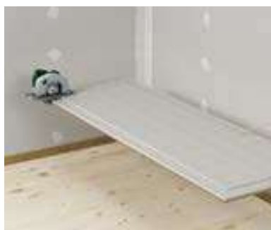
❷ Zaag de overstekende rand van de liplas af bij de wandaansluiting.
