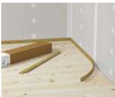
❶ Breng fermacell™ randisolatiestroken langs de wanden aan.
