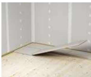
❺ Verlijm de aansluitende fermacell® vloerelementen met volledig gevulde lijmvogen.
